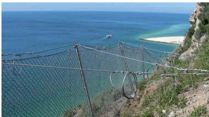
Fig. 1 - Vista generale di una struttura paramassi flessibile a rete
